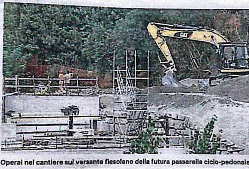
Operai nel cantiere sul versante fiesolano della futura passerella ciclo-pedonale
