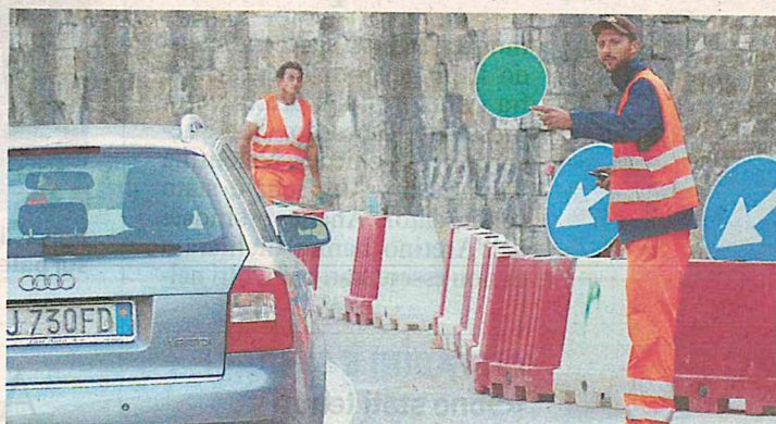
Gli automobilisti devono stringere i denti ancora per alcuni giorni poi spariranno i cantieri dall'Aretina
