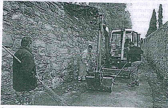
Operai al lavoro per mettere in sicurezza il muro e liberare la strada
